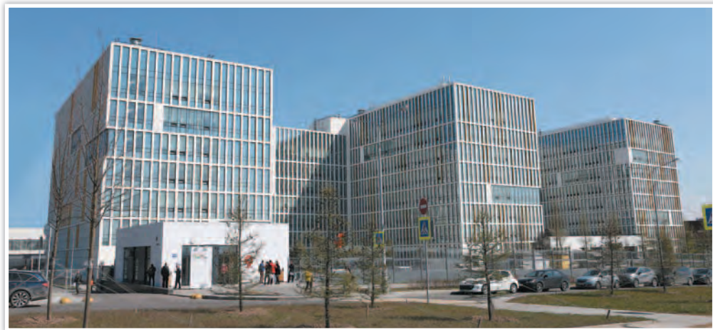
Московский многопрофильный клинический центр «Коммунарка»
